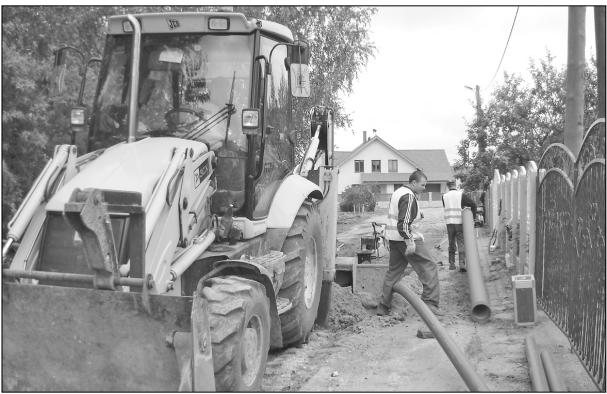
Eiropas Savienības Kohēzijas fonda līdzfinansētā projekta «Ūdenssaimniecības pakalpojumu attīstība Preiļos, II kārtā» ietvaros turpinās maģistrālā ūdensvada un kanalizācijas tīklu rekonstrukcija un izbūve, kas ievērojami palielinās centralizētās ūdensapgādes un kanalizācijas pakalpojumu pārkāpumā Preiļu pilsētā.
