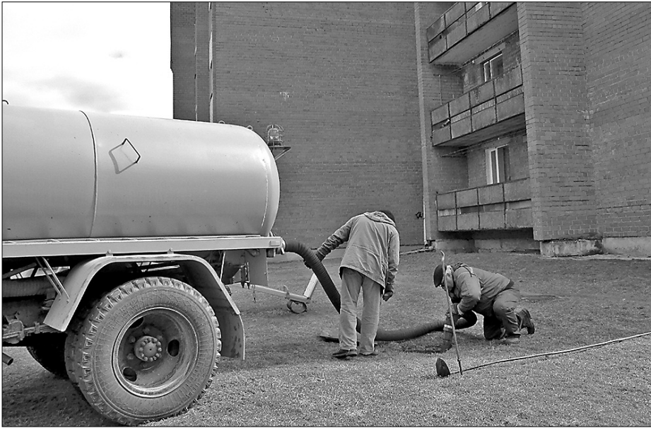
SIA «Preiļu saimnieks» Remontu un celtniecības daļas speciālisti veic notekcauruļu tīrīšanu un remontu N. Rancāna ielas 2. mājai
