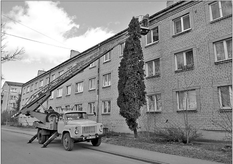
SIA «Preiļu saimnieks» Remontu un celtniecības daļas speciālisti veic notekcauruļu tīrīšanu un remontu N. Rancāna ielas 2. mājai
