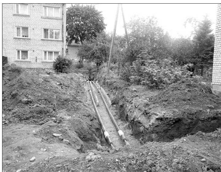
В конце сентября завершились работы по замене участка теплотрассы в районе улиц Механизатору и Пилс. Этот участок трассы был в аварийном состоянии, так как не выдержал проведенного весной гидравлического испытания. Поэтому, чтобы не ставить жителей данного массива под угрозу срыва теплоснабжения, надо было срочно искать решение этого вопроса. Работы по замене теплотрассы были осуществлены при помощи финансирования из бюджета программы 12.00.00 «Поддержка края».
