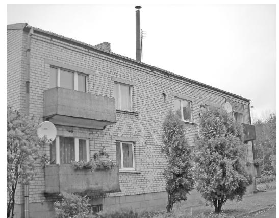
šanā jau pieredze. Projektā paredzēti kompleksi pasākumi siltuma zudumu samazināšanai. Plānots, ka jau šoruden varēs nosiltināt pagrabu un bēniņus, nomainīt jumtu, bet cokolu un ārsienu siltināšana notiks nākampavasarā. Šie pasākumi dos iespēju veikt ne tikai pasīvu, bet arī aktīvu energotaupīšanu, kas būs ļoti efektīvs risinājums.
