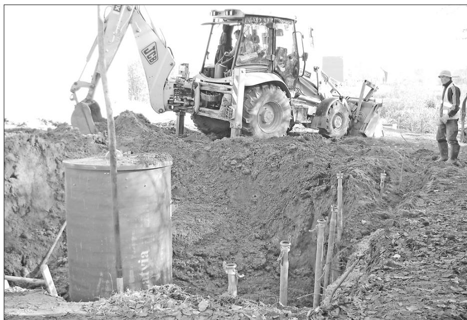
**На снимке: создание станции перекачки канализации в жилом микрорайоне по улице Целтниеку. При помощи станции перекачки сточные воды будут выведены в самосточную систему канализации.**
