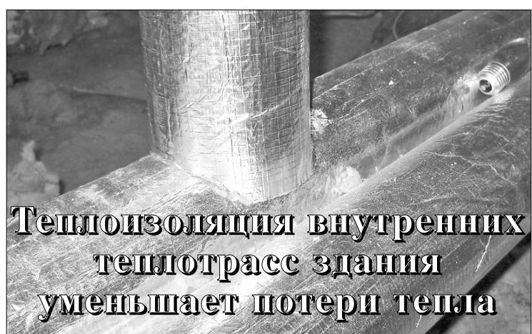
**Теплоизоляция внутренних теплотрасс здания уменьшает потери тепла**
