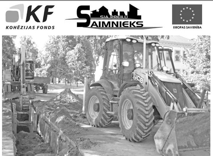
Attēlā: Centralizētā ūdensvada un kanalizācijas tīklu izbūves darbi Raiņa bulvārī. Tas beidzot dos iespēju pieslēgt ēkas izbūvētājiem tīkliem, saņemt kvalitatīvu dzeramo ūdeni un sadzīves noteikūdeņus novadīt kopējā kanalizācijas tīklā.
